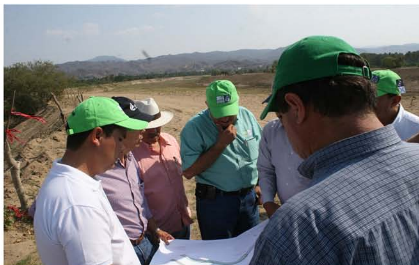
Supervisión de obras en el río Marabasco con Conagua
