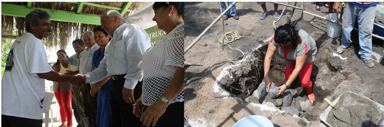
Junto con la Federación, iniciamos con la construcción de una lonja pesquera en El Paraíso, Armería
