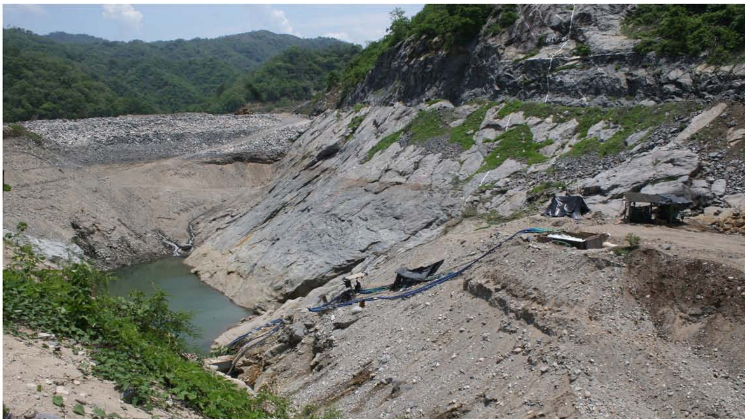
Visita de supervisión a la presa El Naranjo II con el Gobernador del Estado, Mario Anguiano Moreno, acompañado del director general del Organismo de Cuenca Lerma-Santiago-Pacífico de la Comisión Nacional del Agua (Conagua), José Elías Chedid Abraham. La obra, con una inversión de 120.4 millones de pesos durante 2013 presenta un avance del 45 por ciento.
