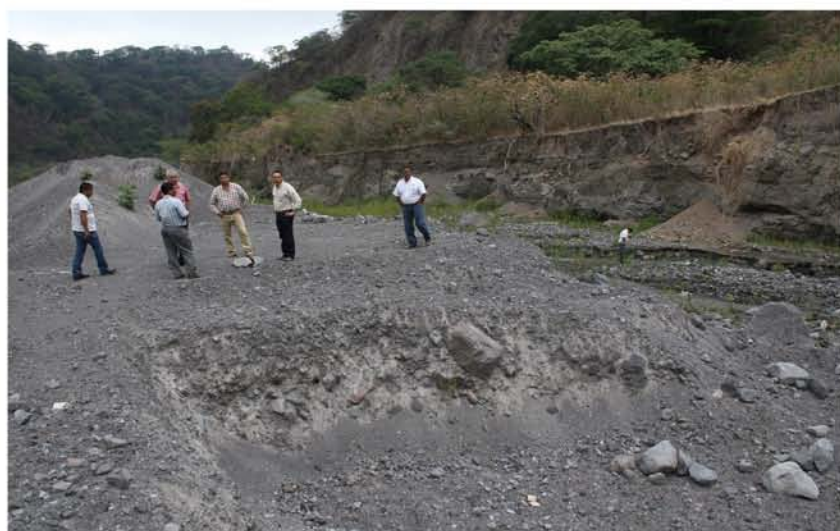
Supervisión río La Lumbre en Comala durante las primeras lluvias
